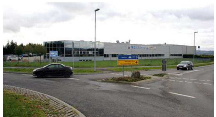
Erst das beleuchtete Fachbetriebszeichen in der Grünfläche verrät, dass in diesem modernen Gebäudekomplex ein Karosseriefachbetrieb untergebracht ist
