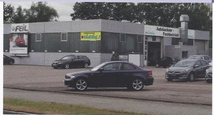
Gemeinsam unter einem Dach: Am Standort Gunzenhausen hat Kießling die Lackierabteilung komplett vom örtlichen BMW-Händler übernommen. Dieser ist jetzt – neben anderen Autohäusern – sein bester Kunde
