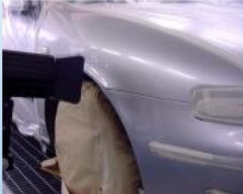
Ablüßzeit 1 Minute für Basislack auf Lösungsmittelbasis oder 2 Minuten für Basislack auf Wasserbasis und Trocknung mit UV Lampe für 1 Minute.
